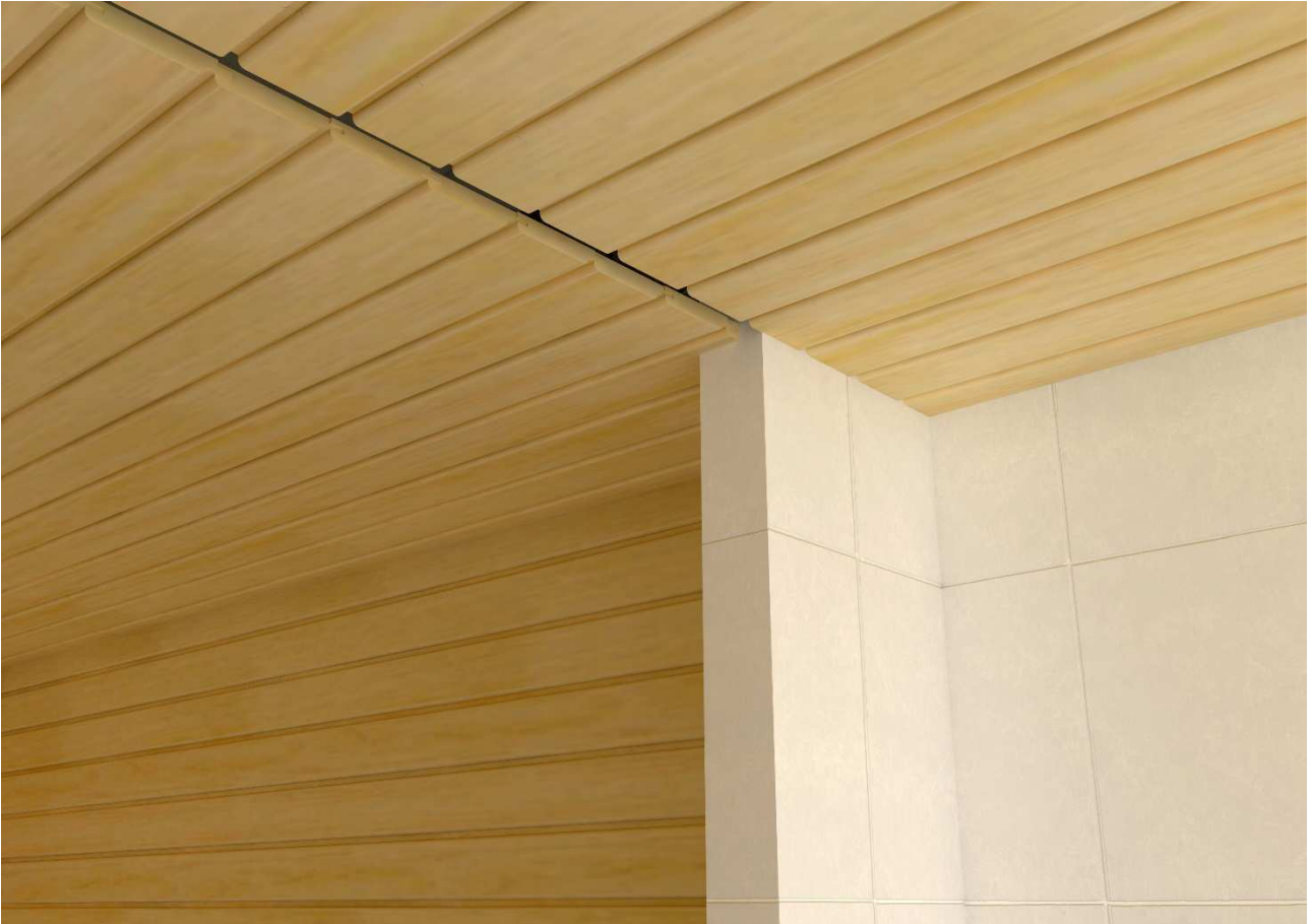
kuva 17. saunan ja pesuhuoneen liitos
