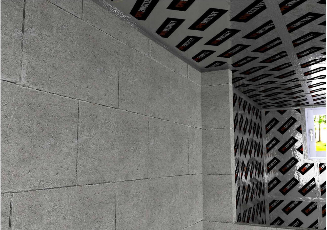
kuva 7. alumiiniteippi katon ja seinän rajassa
