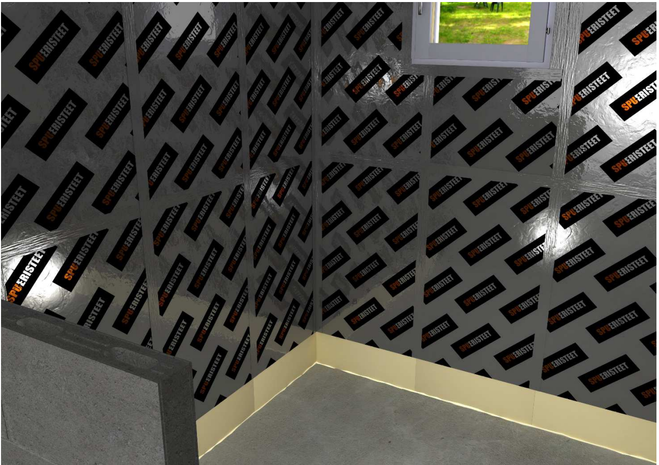
kuva 9. alumiinipaperi poistettu 200mm asti
