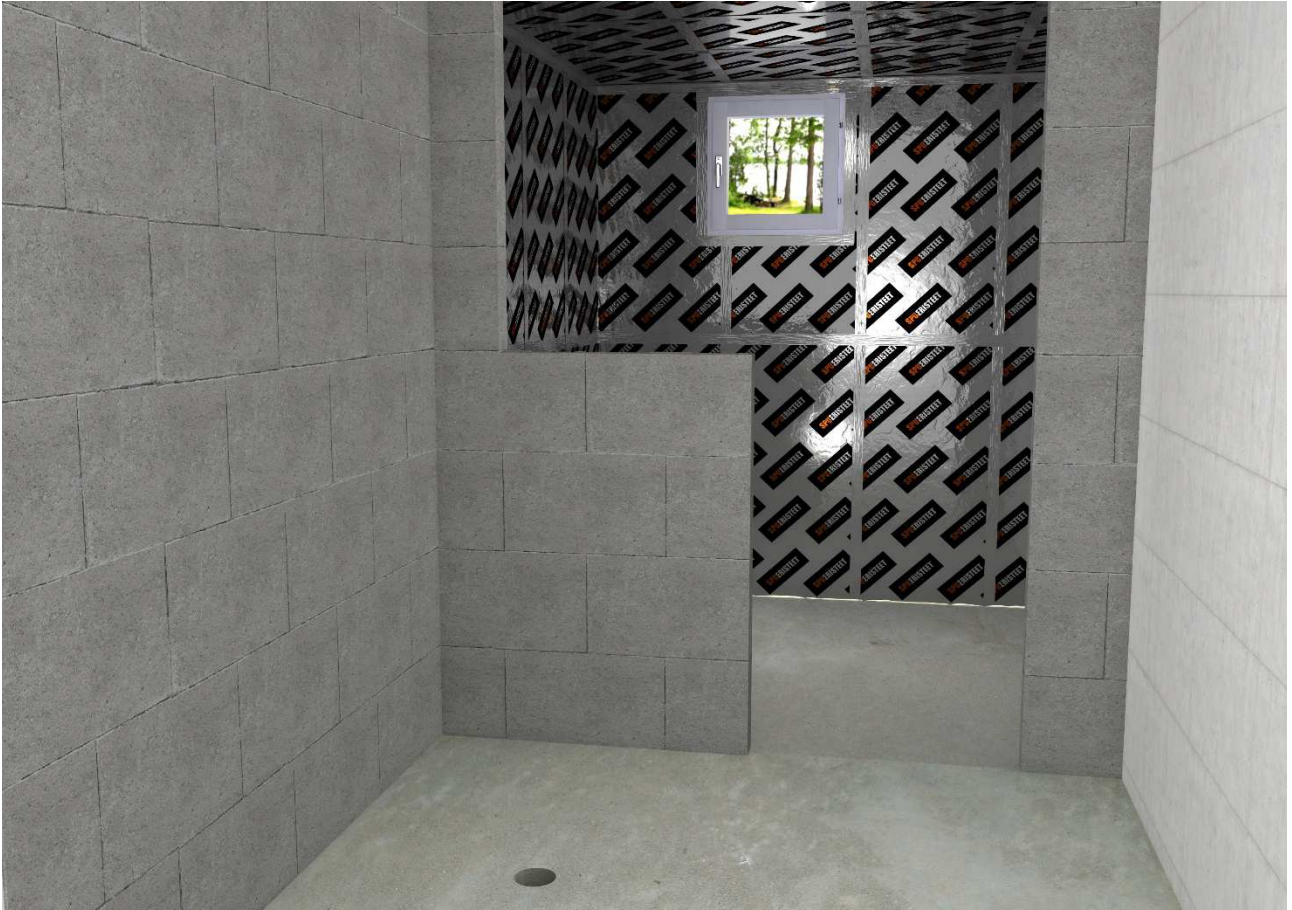
kuva 6. saunan eristys valmis
