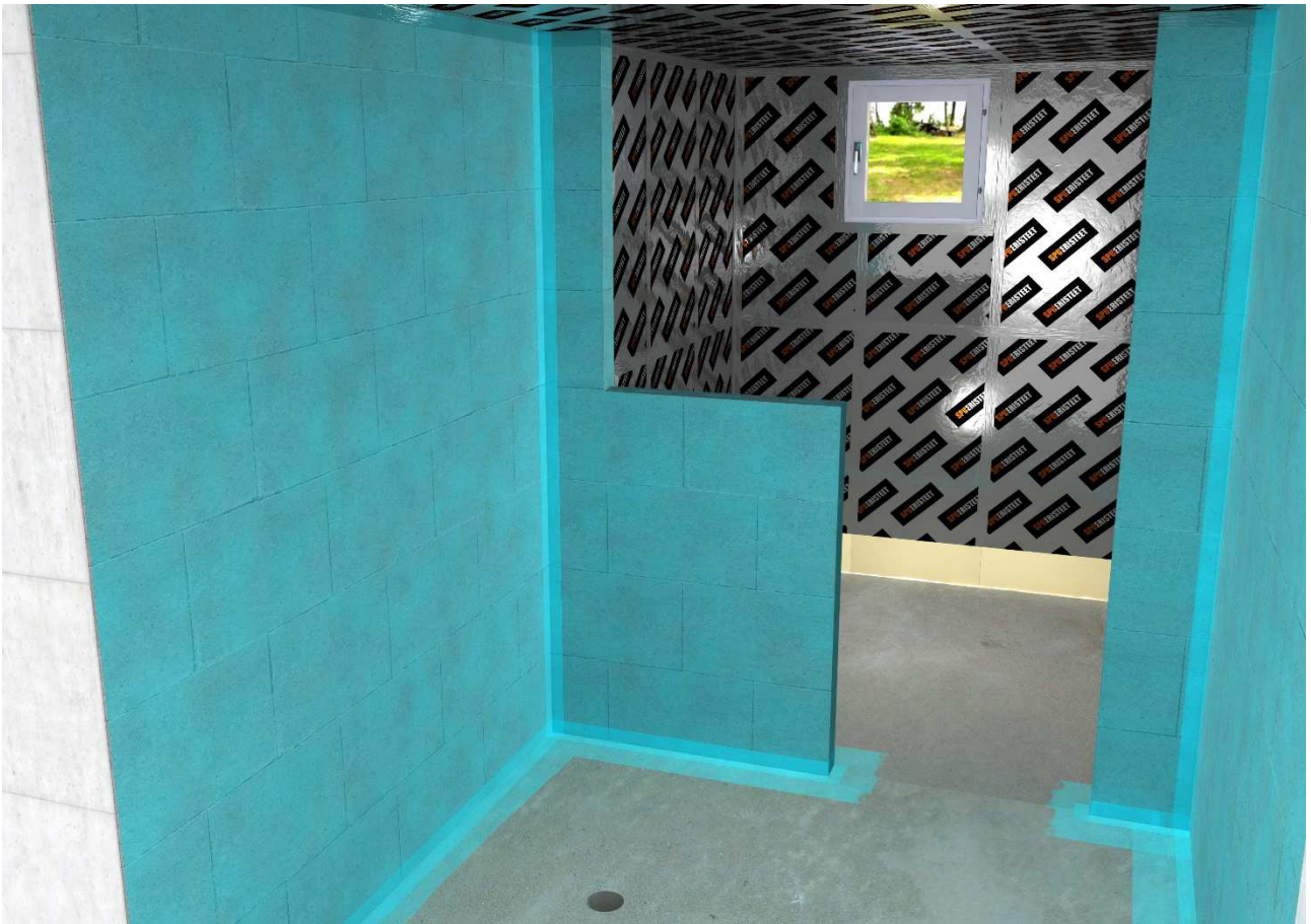
kuva 10. pesuhuoneen vedeneristys
