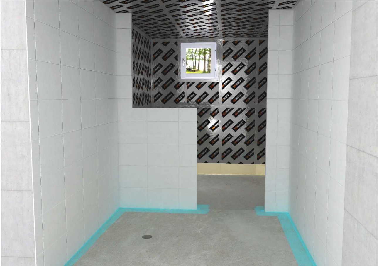
kuva 12. pesuhuoneen seinälaatoitus valmis
